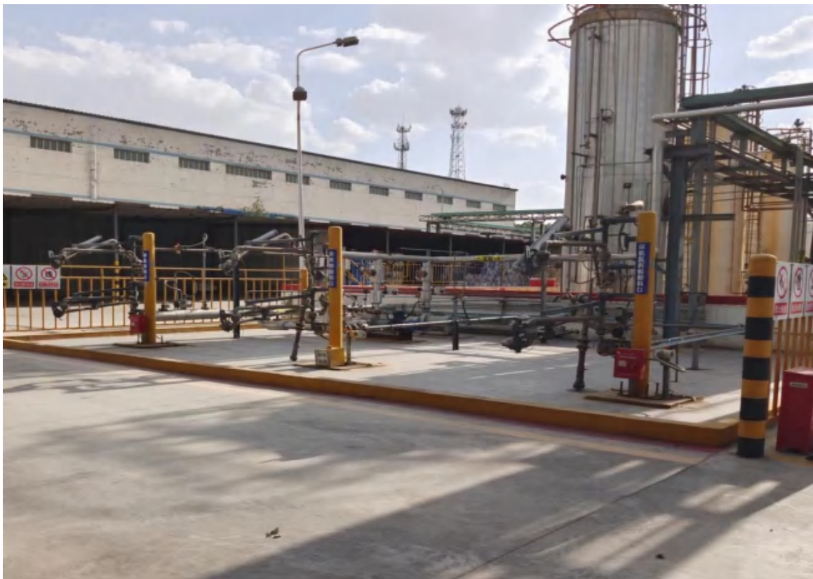
鹤管装卸区 1 地面硬化、围堰
