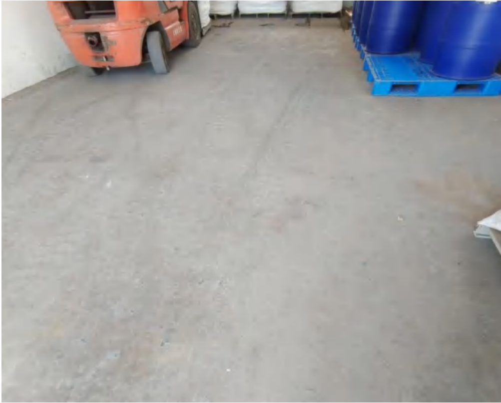
1#丙类库房地面防渗
