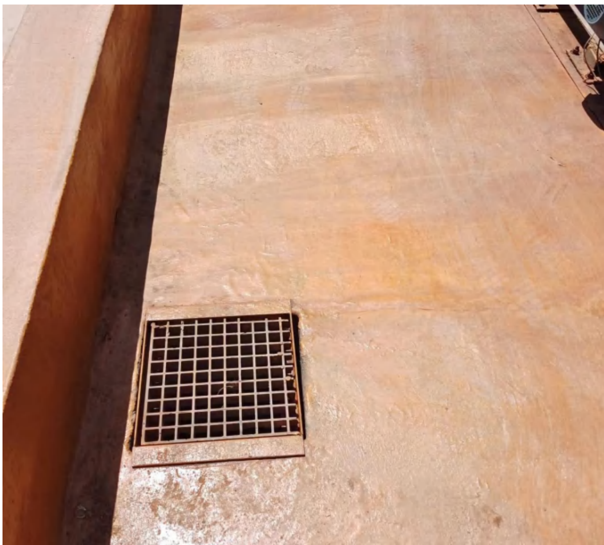
图 4.1.1-3c 二车间中间罐收集池
