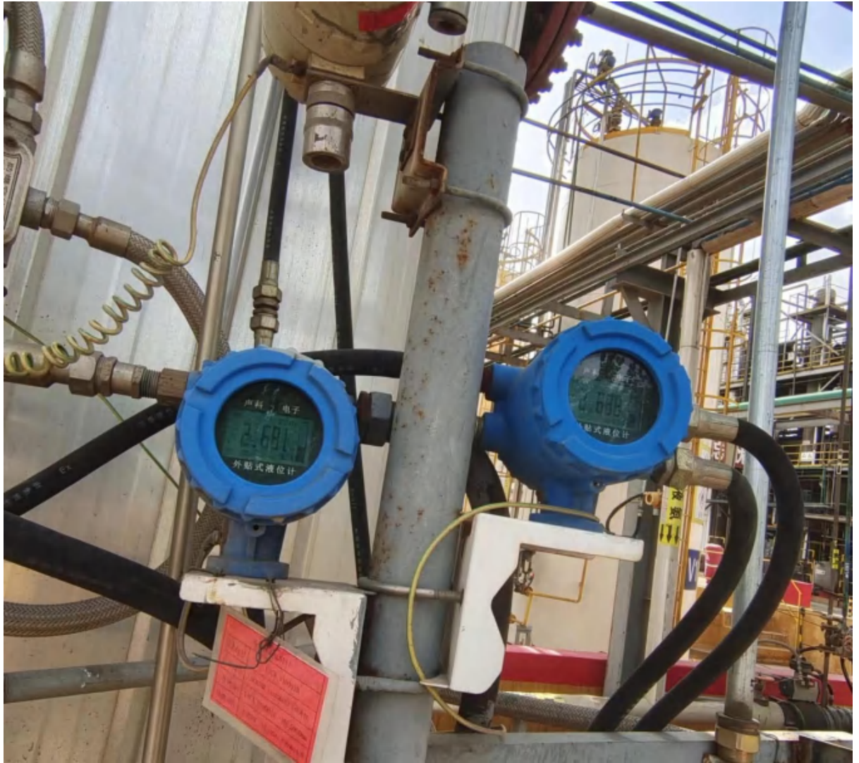
图 4.1.1-1h 罐区 2 外贴式液位计
