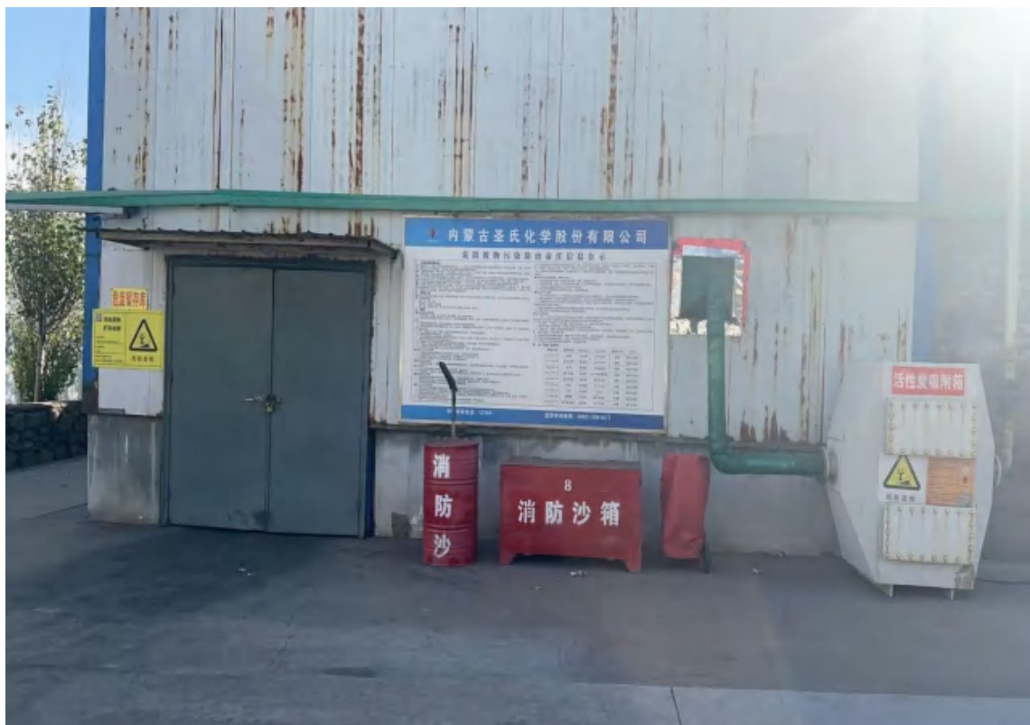
危废暂存间外观
