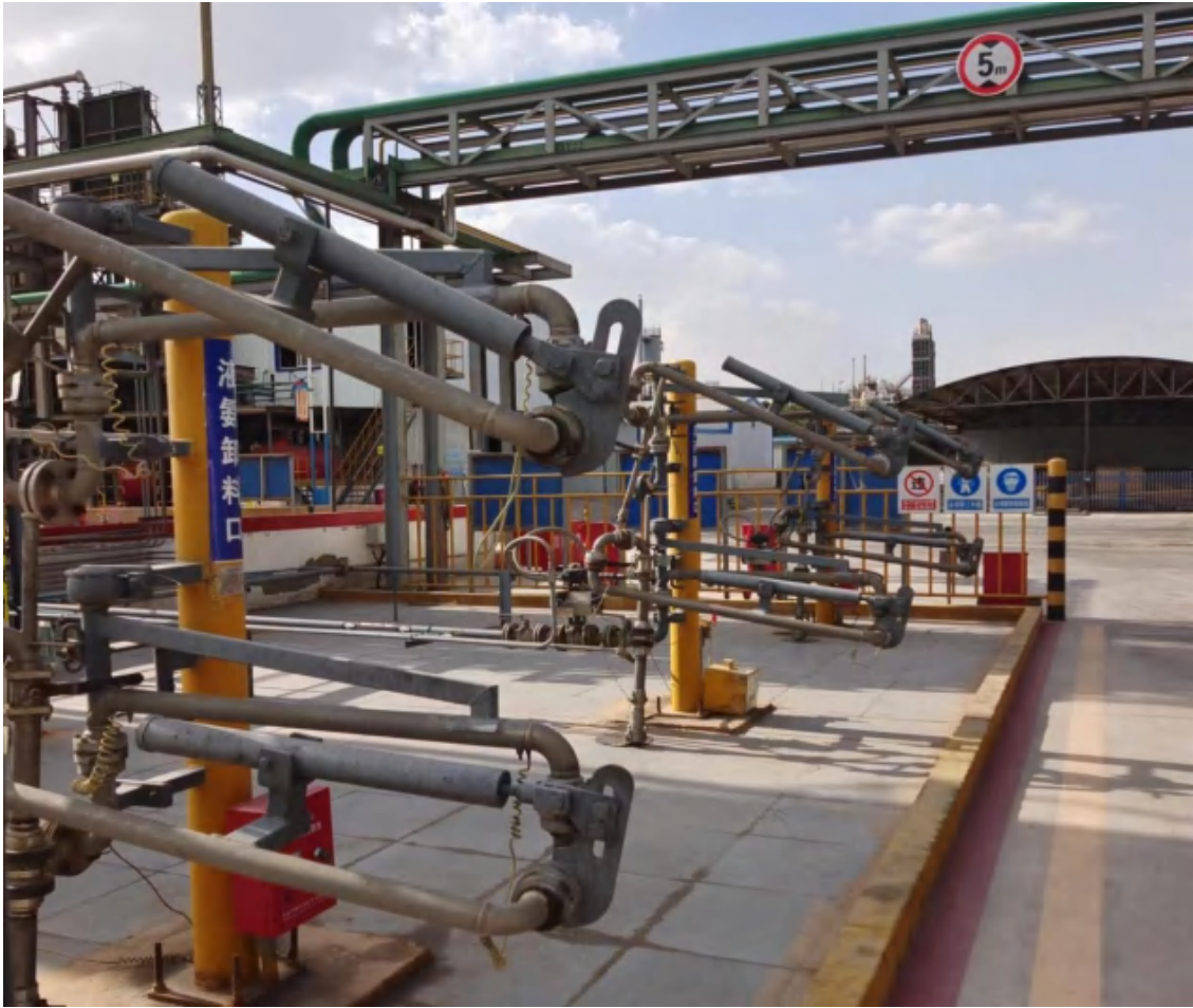
鹤管装卸区 2 地面硬化、围堰
