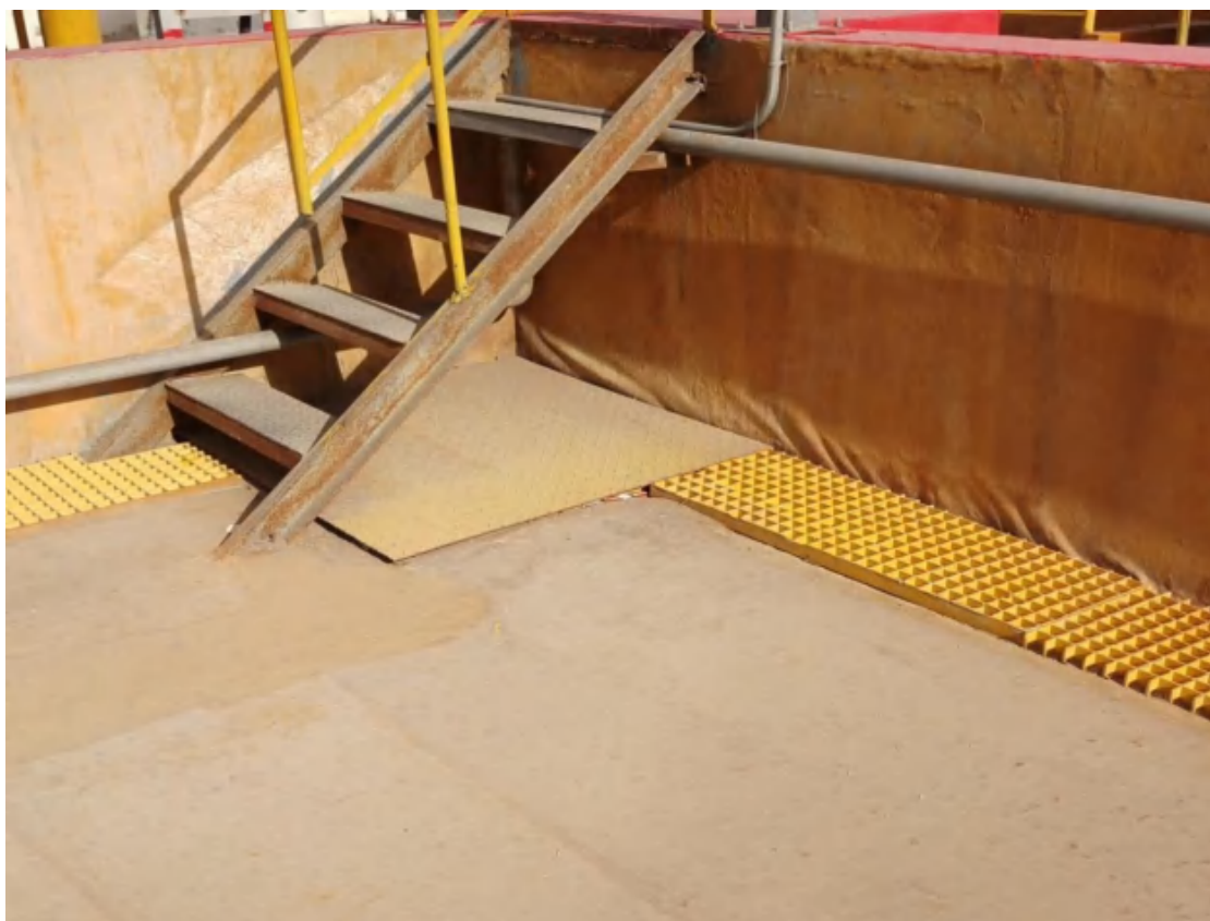
储罐区收集池
