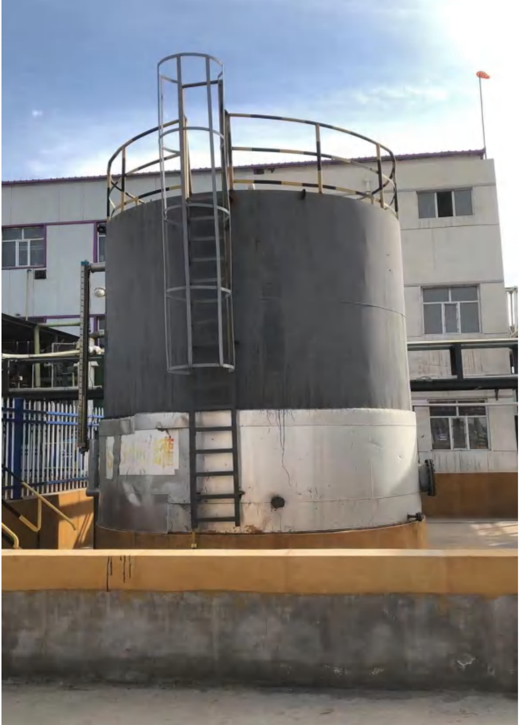
图 4.1.1-2 罐区 1 围堰、储罐
