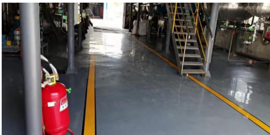
一车间三工段地面防渗
