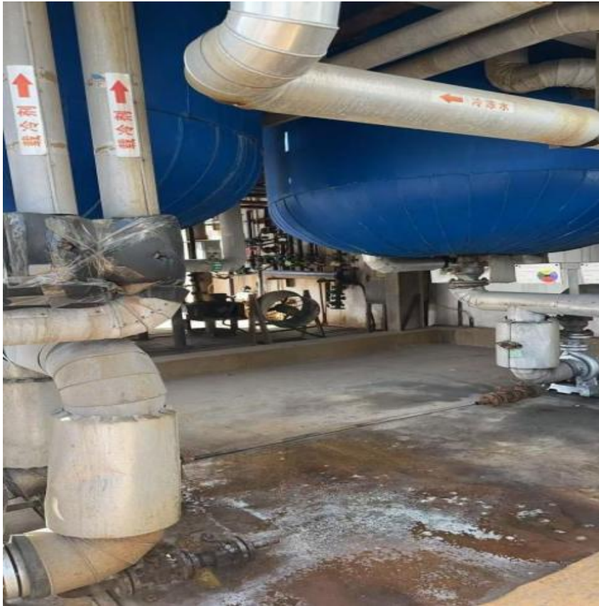
载冷剂釜下方地面
