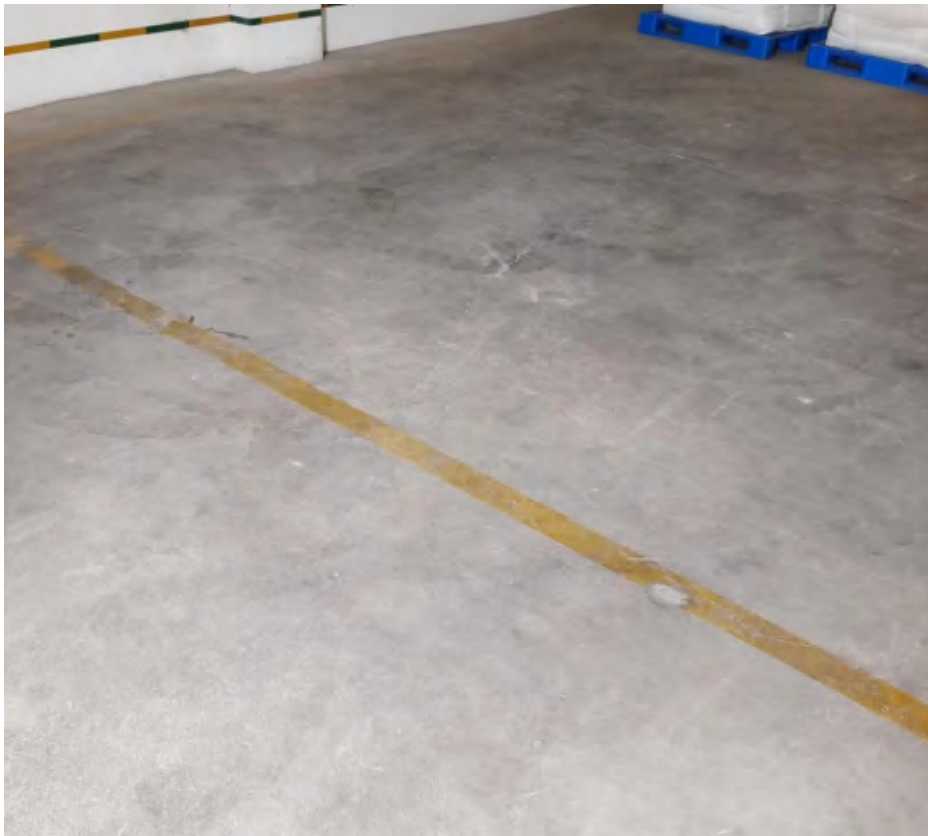
2#丙类库房防渗地面
