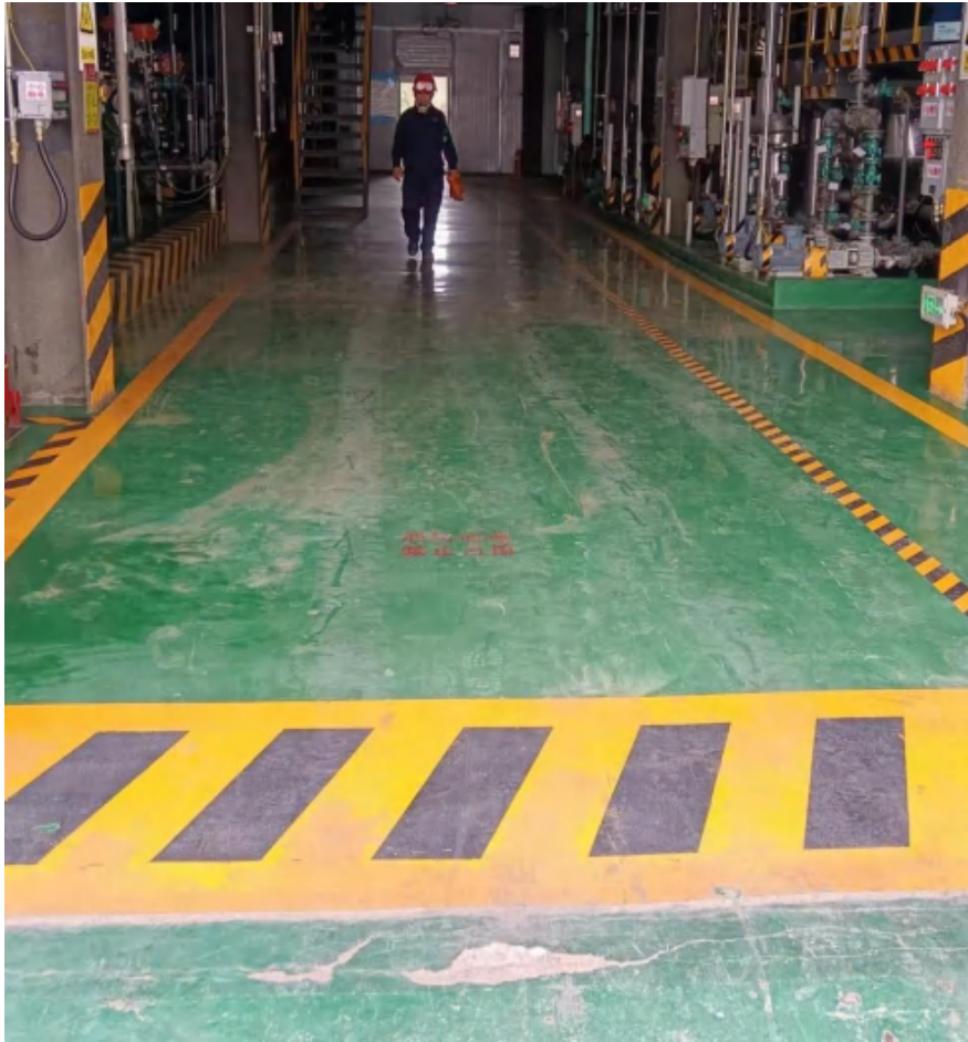
五车间地面防渗
