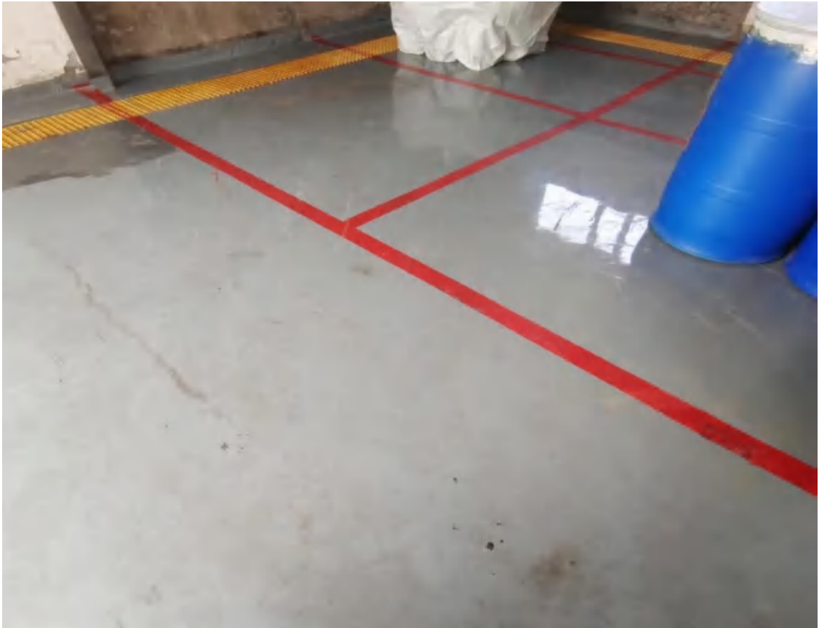
危废暂存间地面
