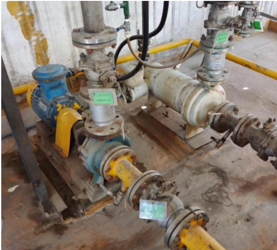
一车间泵体地面
