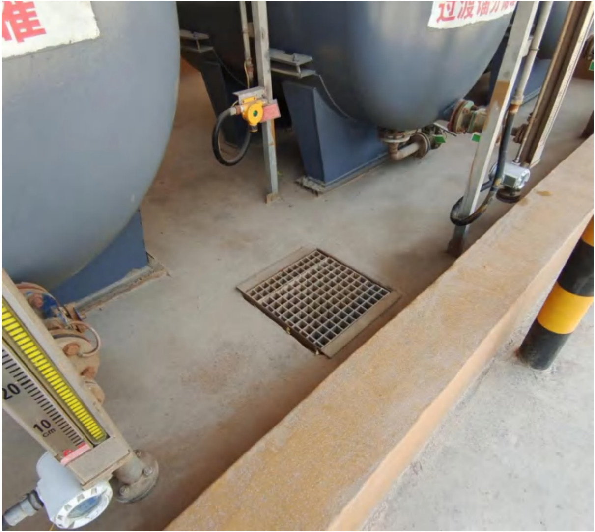
图 4.1.1-3d 二车间中间罐围堰
