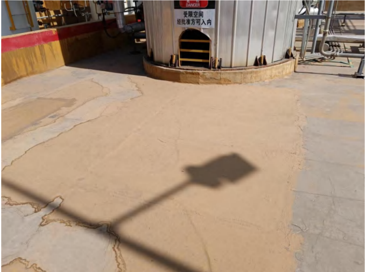
图 4.1.1-1a 罐区 1 地面硬化、防渗
