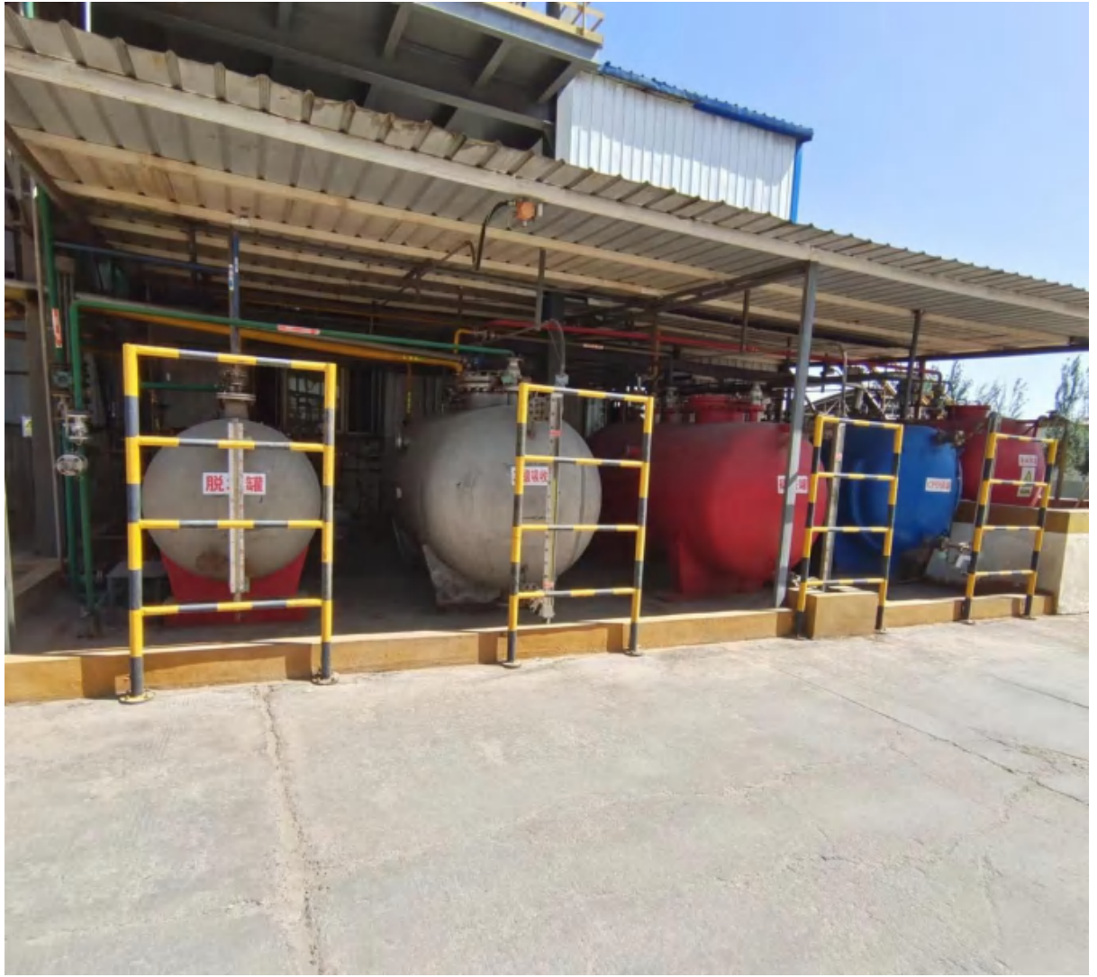
图 4.1.1-3a 一车间中间罐
