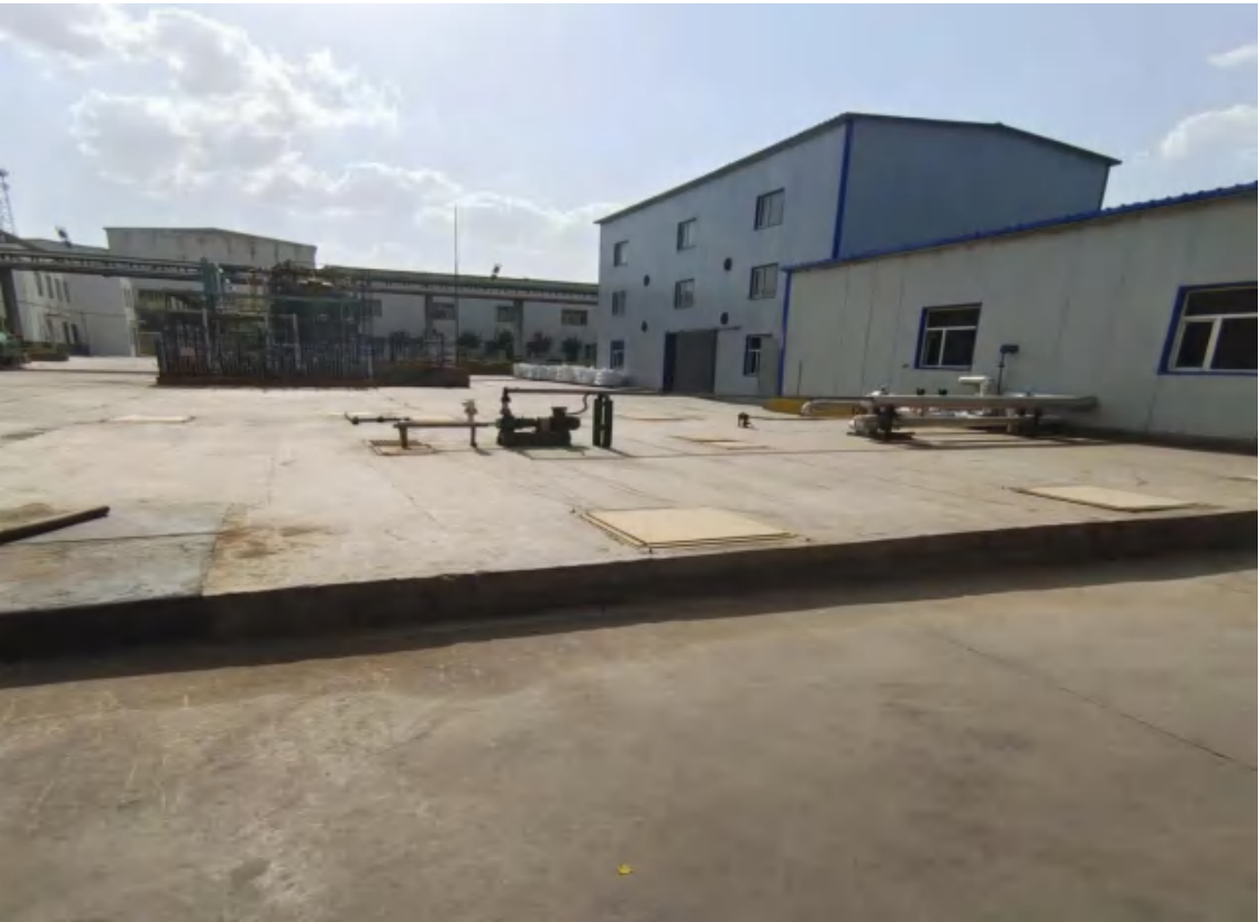
污水处理站地下水池
