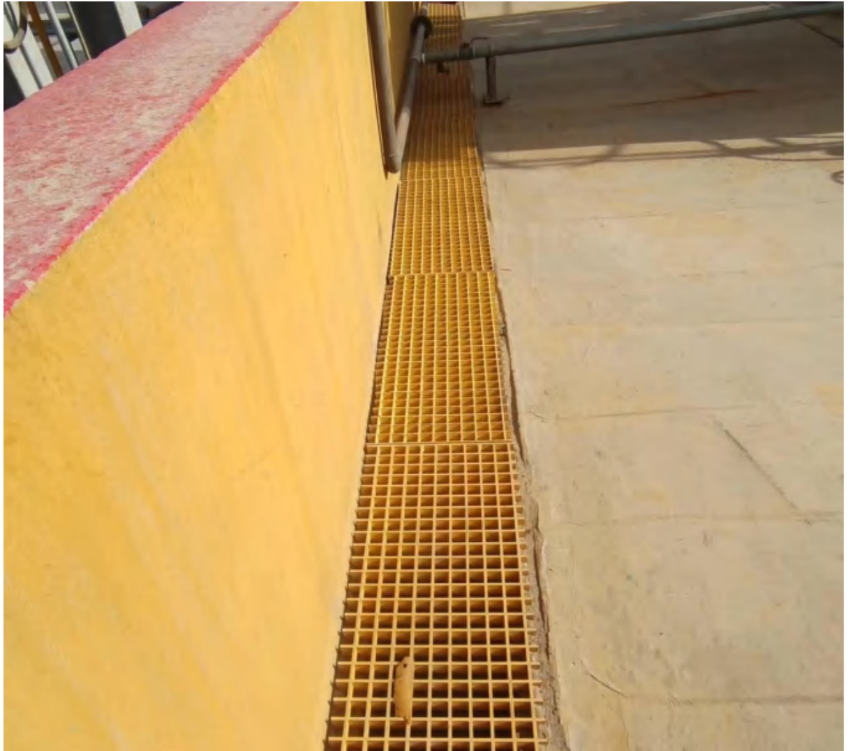
图 4.1.1-1g 罐区导流槽
