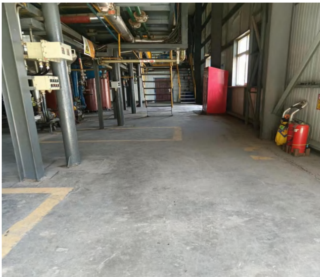
一车间一工段地面防渗
