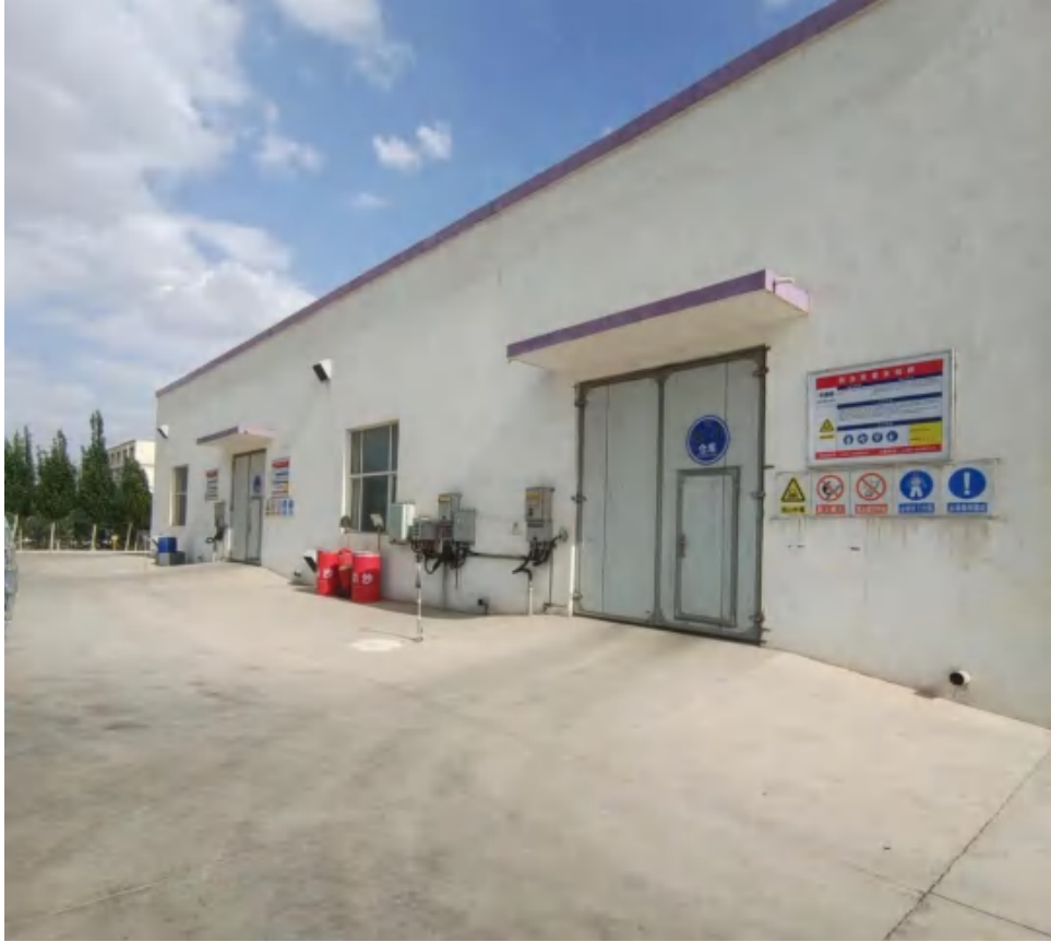
甲类库房外观、周围防渗
