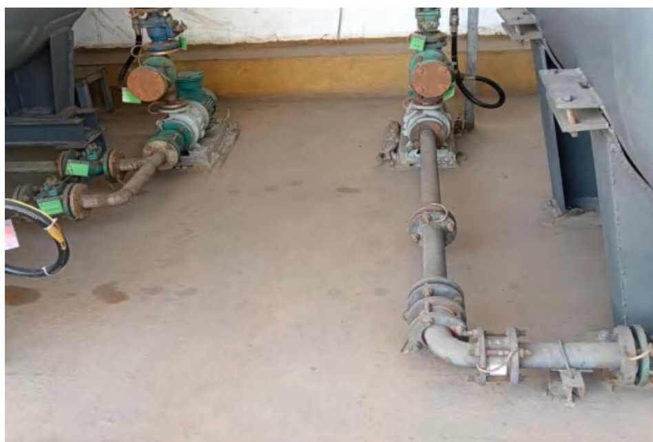
二车间防渗地面
