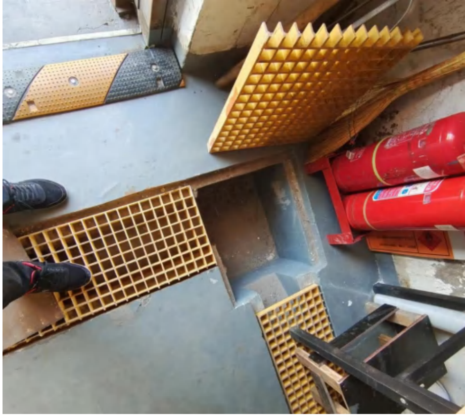
危废暂存间收集池
