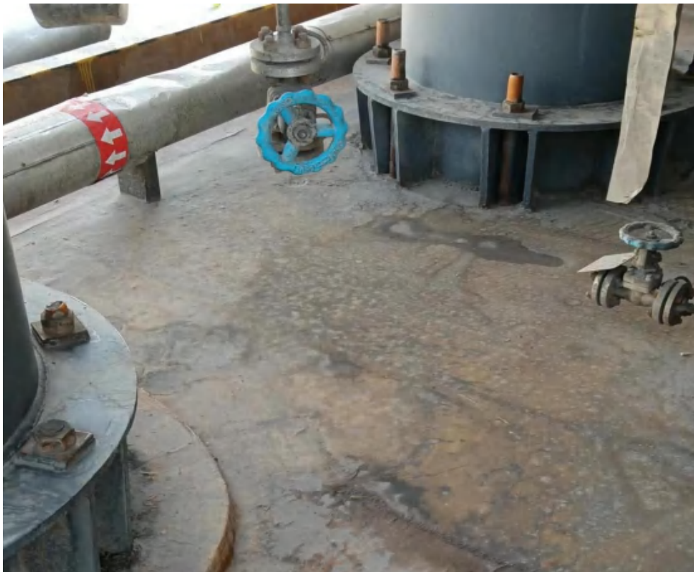
六车间地面防渗、防腐
