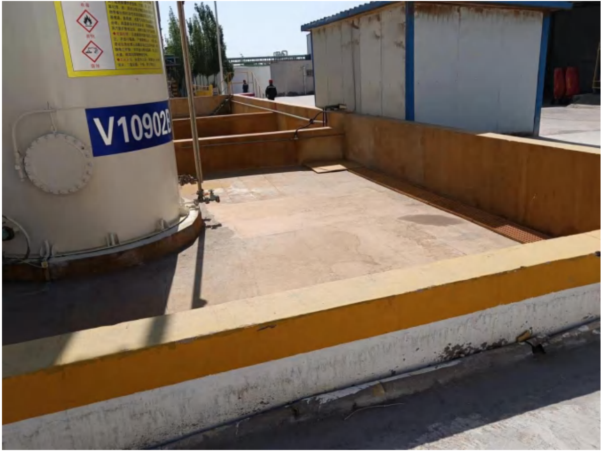
图 4.1.1-1d 储罐区 围堰
