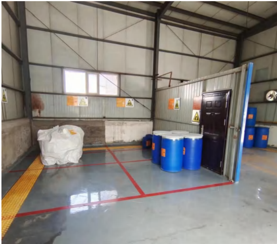
危废暂存间分区堆存
